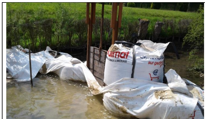
Installation d'une vanne au centre du batardeau
