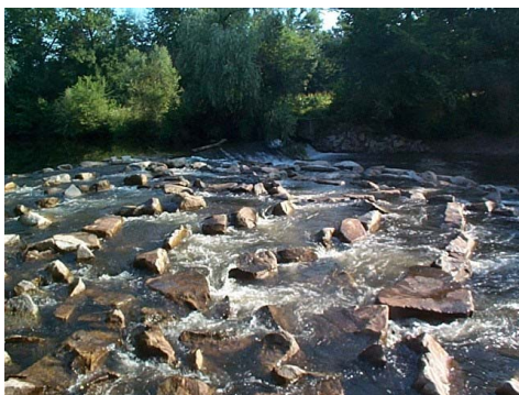
Figure 20 : Rampe en enrochements périodiques à Kolbsheim : vue avant aménagement, vues depuis l'aval en étiage et en crue.
