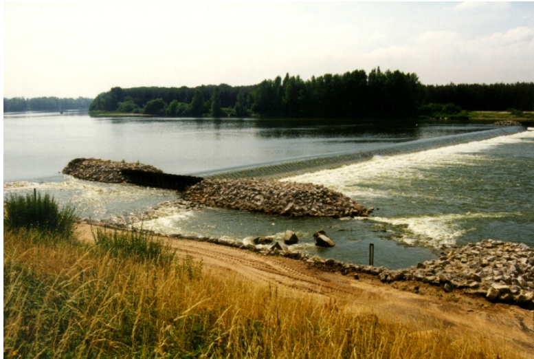
Figure 15 : Seuil de Dampierre sur la Loire équipé sur chaque rive de débarrages constitués de rampes en enrochements jointifs
