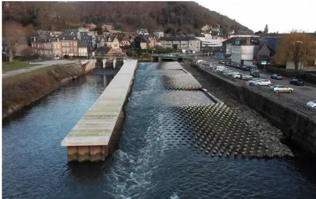
La passe à poissons du barrage de la Madeleine, sur la rivière Risle à Pont-Audemer dans le département de l'Eure, est un ouvrage unique en France. #PRESSE30
